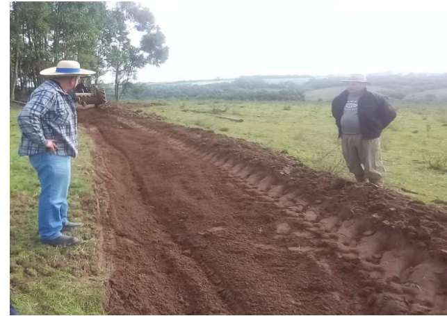
Construção de terraços em campo nativo solos arenosos - Formigueiro
