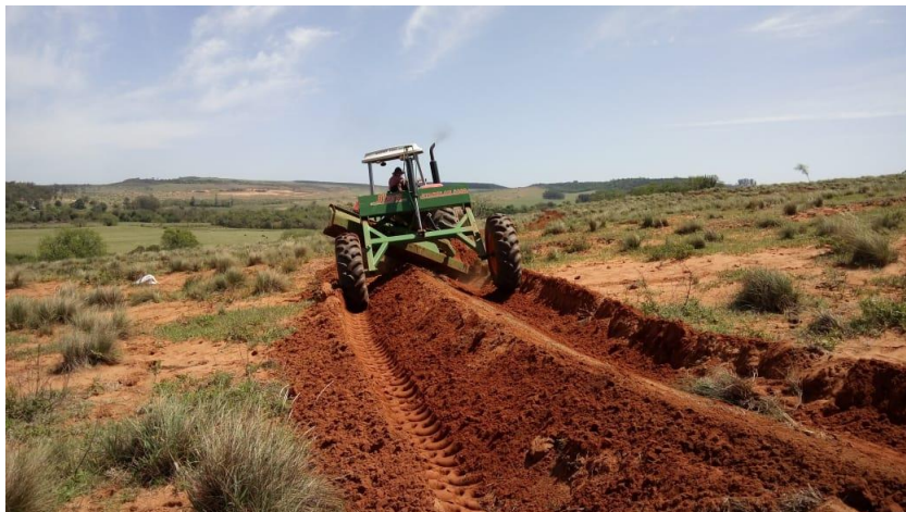
Construção de terraços em campo nativo São Francisco de Assis
